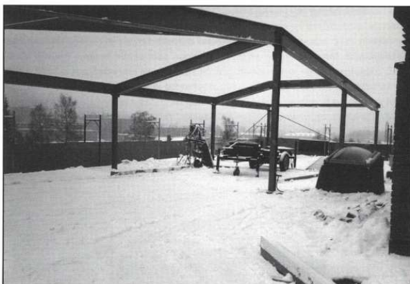
Her har mann begynt å sett opp rammeverket for en ny etasje.
