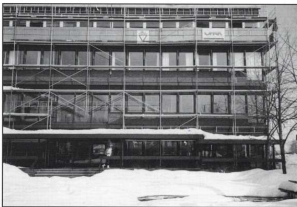
Fra arbeidene med påbygging av 4. etasjen.
